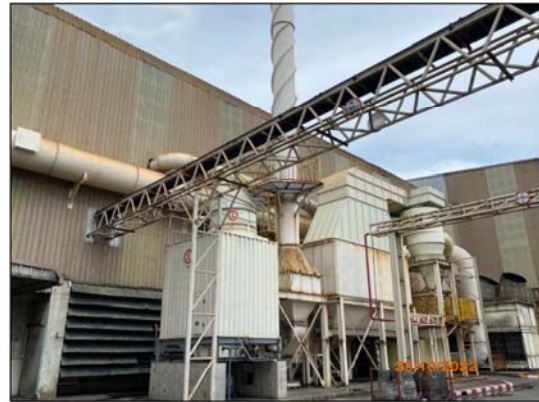
ภาพที่ 2.2-2 Cyclone และ Bag House Filter จากการผสมทราย
