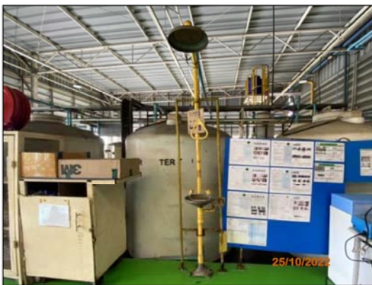
ภาพที่ 2.2-38 อุปกรณ์และแผนผังตำแหน่งติดตั้งอุปกรณ์ล้างตาและฝักบัวฉุกเฉิน
