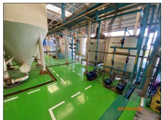
ภาพที่ 2.2-24 ระบบบำบัดน้ำเสียทางเคมี
