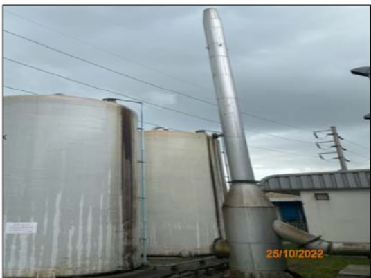
ภาพที่ 2.2-5 ปล่องระบายอากาศจากหม้อไอน้ำ
