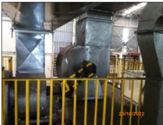
ภาพที่ 2.2-9 พัดลมดูดอากาศ
